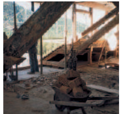
Oben: Korridor während der Renovation Unten: Zimmerausbauten
